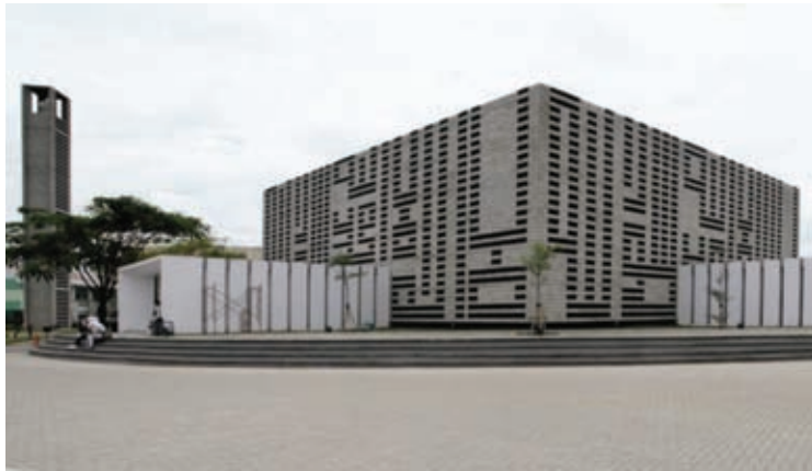
Gambar 4.26 –Perletakkan Entrance Timur dan Entrance Selatan pada Foto Lapangan Masjid Al-Irsyad
