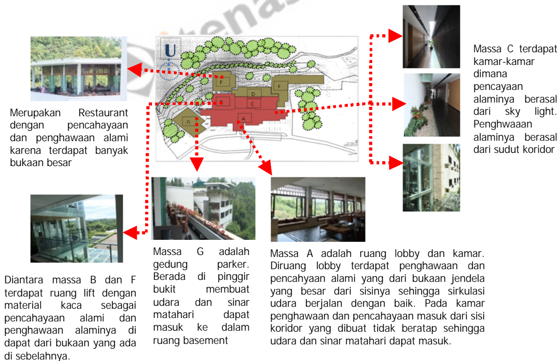
Gambar 3.11 Massa bangunan yang terdapat penghawaan dan pencahayaan alami bangunan Hotel Padma Sumber : PT. Trigana Putra Mandiri (diolah) dan Foto survey 7 November 2013
